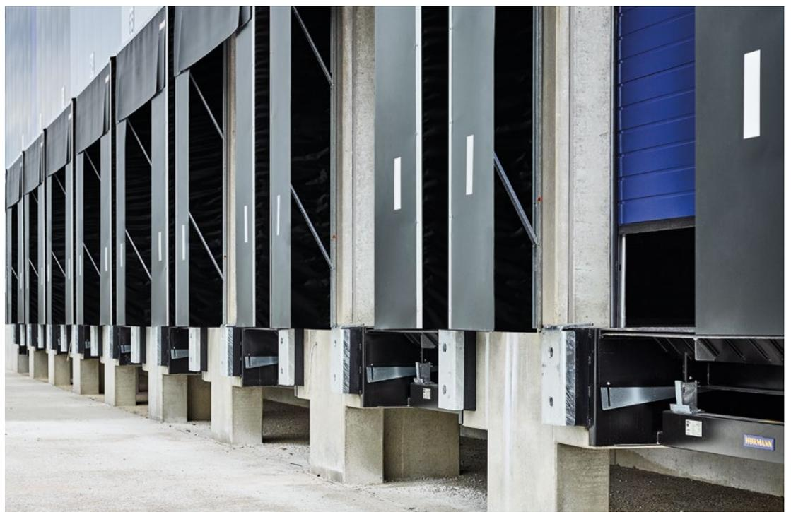
EN HAUT. Les butoirs DB15 et DB20 en caoutchouc ou PU protègent des dégâts dus aux forces d'accostage.
