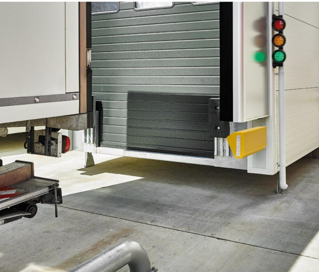
EN HAUT A GAUCHE. Le guide-roues en acier assiste le chauffeur lors de l'accostage. La cale de chargement WSPG avec capteur libère le quai de chargement uniquement après le contact avec la roue.
