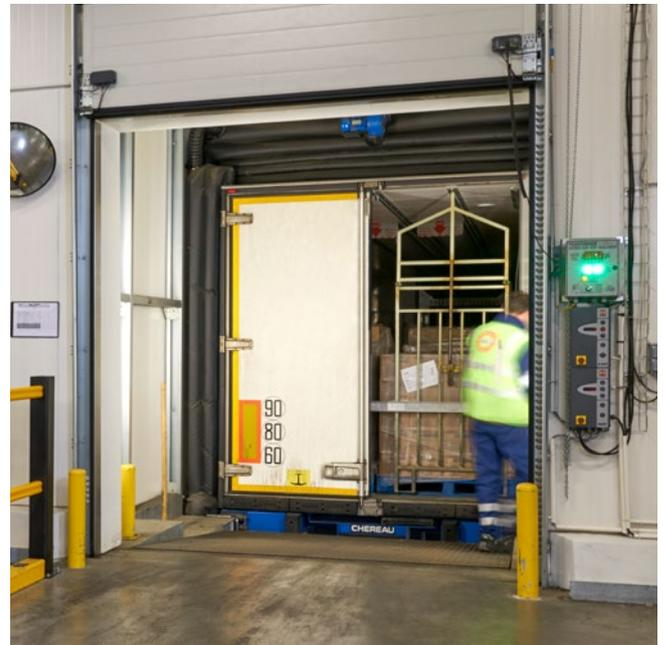
**RAPIDITÉ.** Avec le système DOBO, environ 5 minutes sont gagnées par camion lors de l'accostage, car le chauffeur ne doit pas descendre au préalable pour ouvrir les portes du camion. En outre, les containers peuvent être mis à quai le soir et déchargés directement le lendemain matin.
