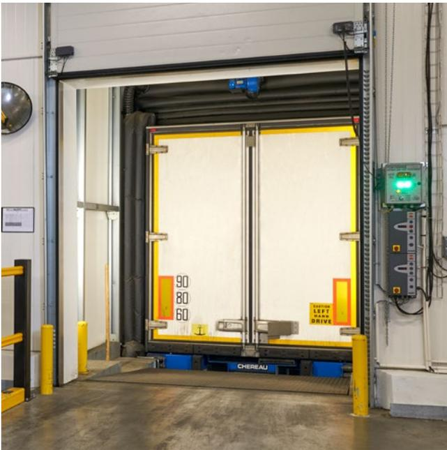
Avec le système DOBO, le camion peut accoster les portes fermées, puis les ouvrir et les ranger dans le bâtiment après l'ouverture de la porte.
